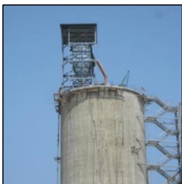
Fly ash silo
